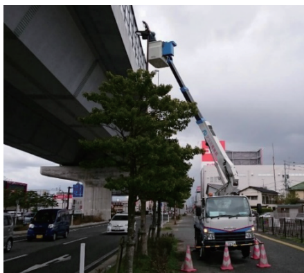
▲照明灯維持管理
