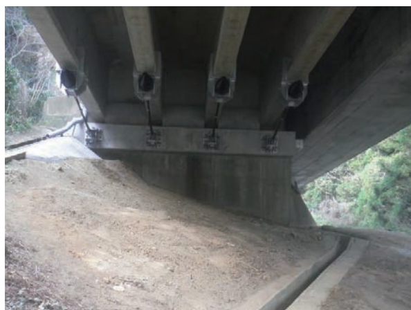
▲耐震補強(落橋防止)
