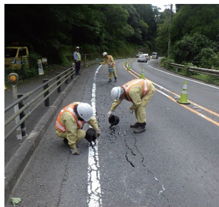
▲ひび割れの補修
