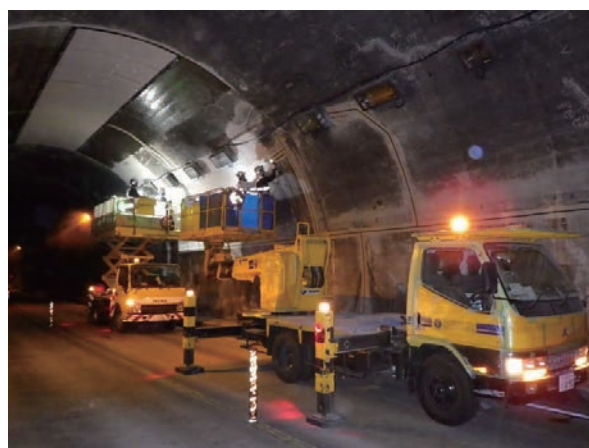
▲トンネル補修
