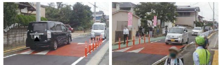
実証実験（可搬型ハンブを設置）（古賀市）
