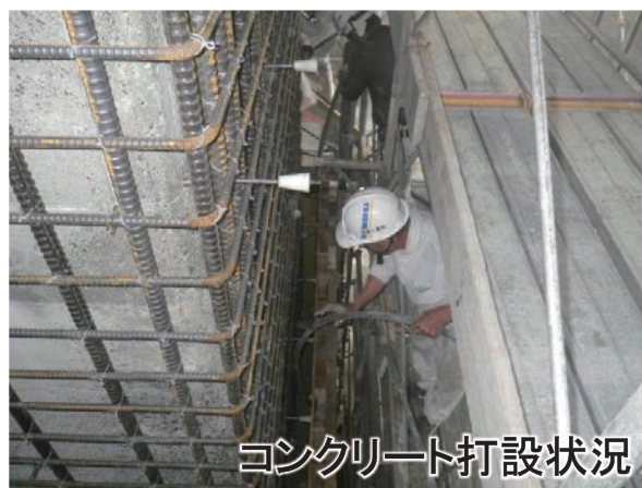
▲耐震補強(柱部コンクリート巻立)
