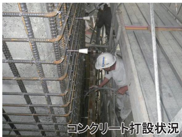
▲耐震補強(柱部コンクリート巻立)
