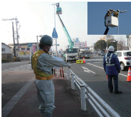
▲照明灯維持管理
