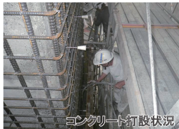
▲耐震補強(柱部コンクリート巻立)
