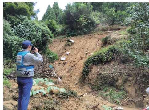
▲被災状況調査(氷川町)
