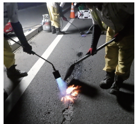
▲ひび割れの補修
