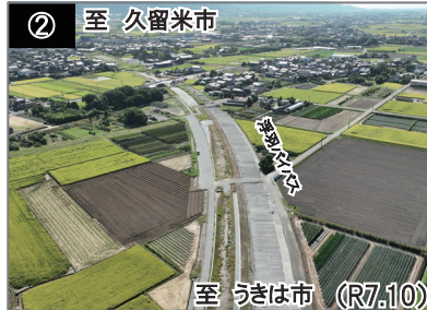
▲ 施工状況 (久留米市田主丸)
