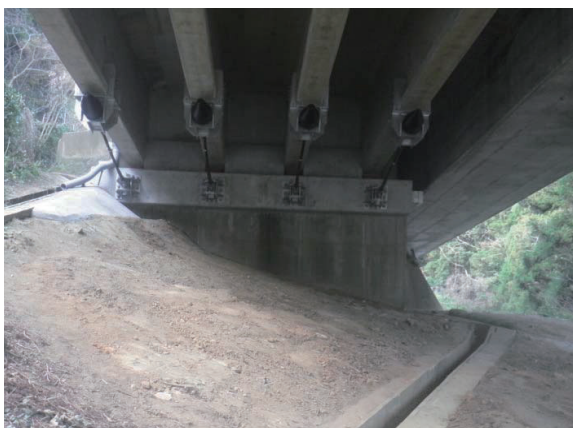
▲耐震補強(落橋防止)
