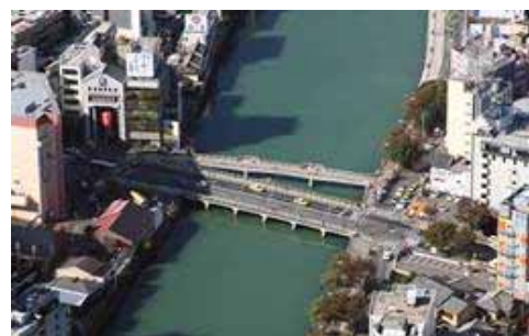
上空(上流側)より春吉橋を望む
