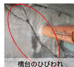
老朽化に伴う春吉橋の損傷
