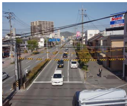
旭町交差点付近から 終点側を望む
