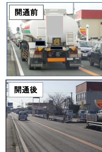
▲国道208号みやま市高田町
