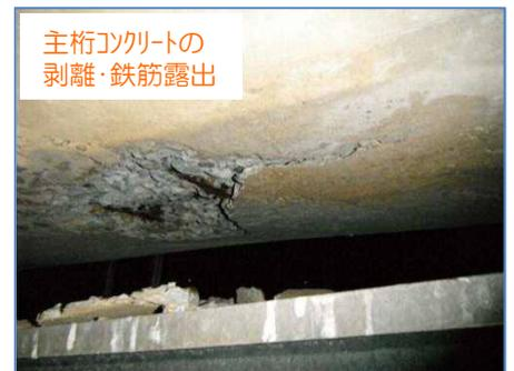
浦島橋は、昭和31年に架設されて以来58年余り経過しており、橋の損傷が激しく、これまで補修・補強工事を行ってきましたが老朽化が進んでいます。
