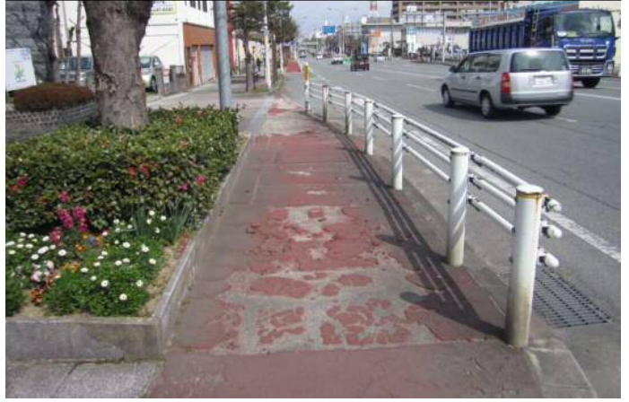
自転車道（経年劣化）
