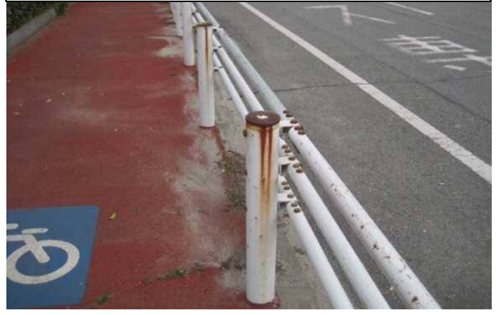
防護柵（ガードパイプ劣化）
