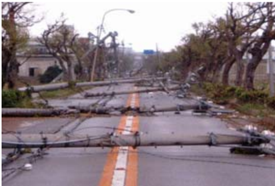
電柱の倒壊による道路閉塞
