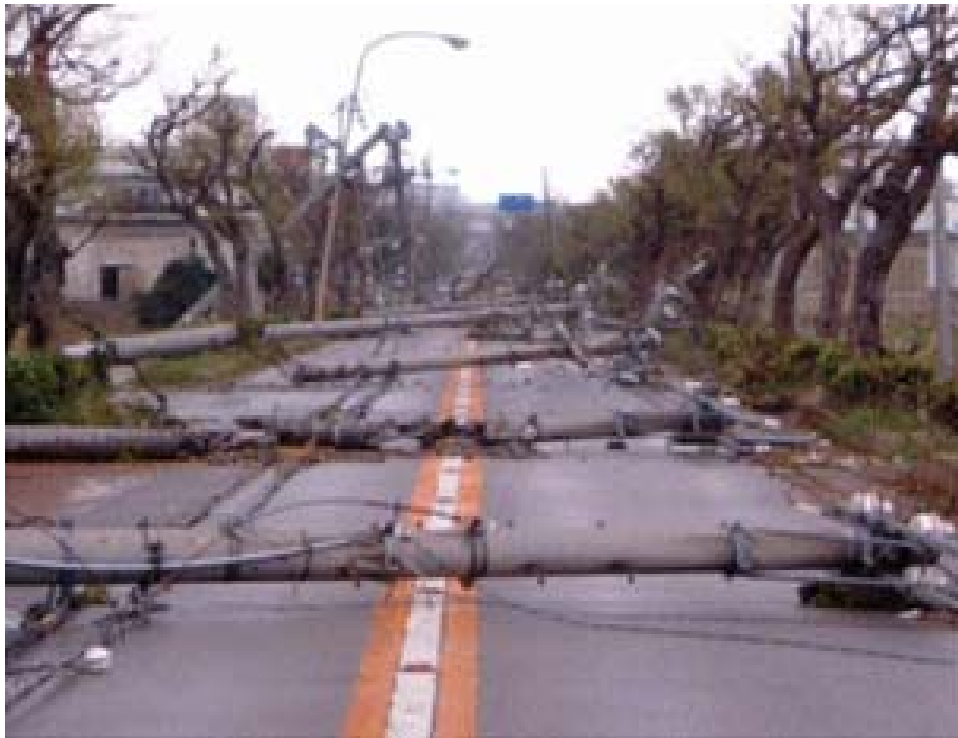
電柱の倒壊による道路閉塞
