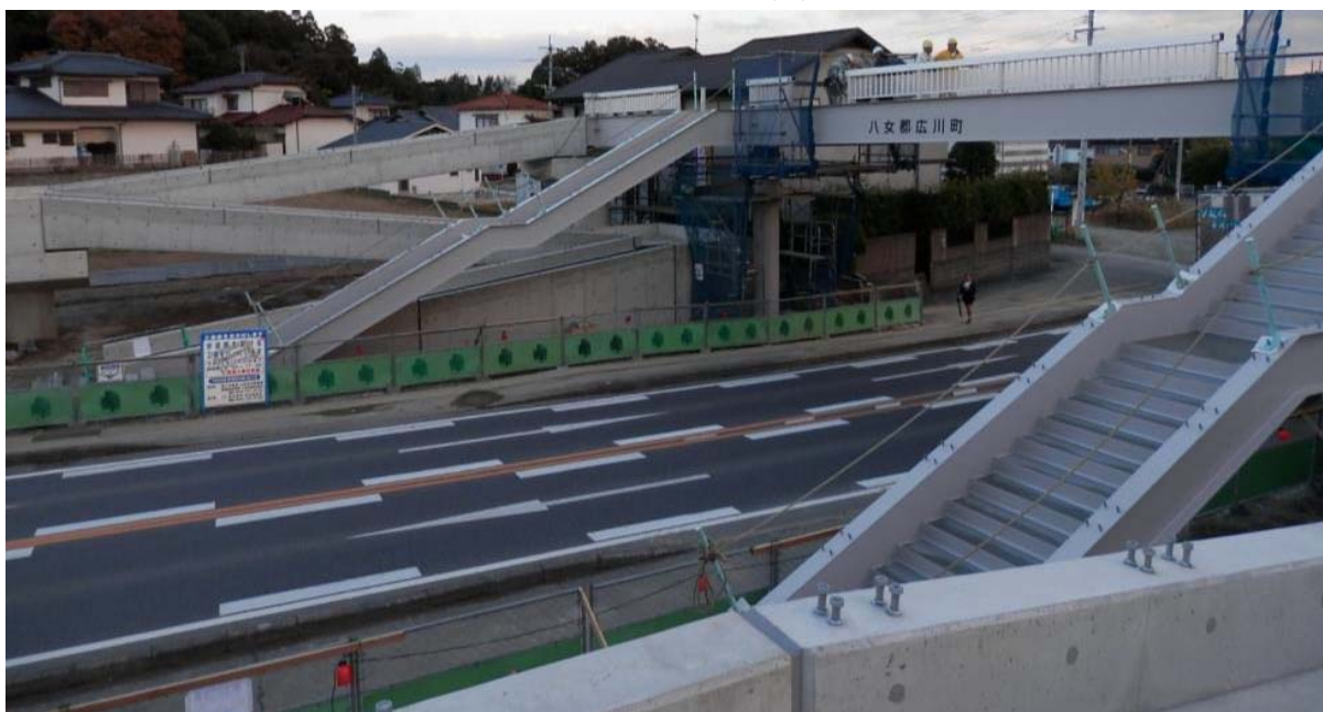
▲新代横断歩道橋（愛称：ぴんぴん歩道橋）の全景
