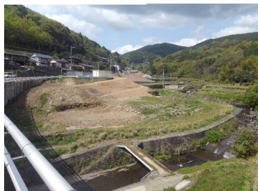
管理用道路施工箇所
