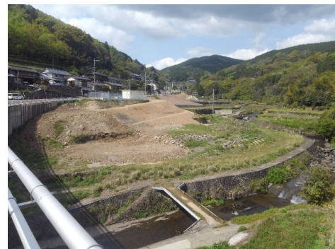
管理用道路施工箇所
