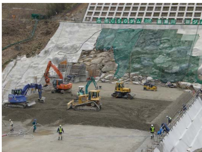
振動ローラ施工状況(遠景)
