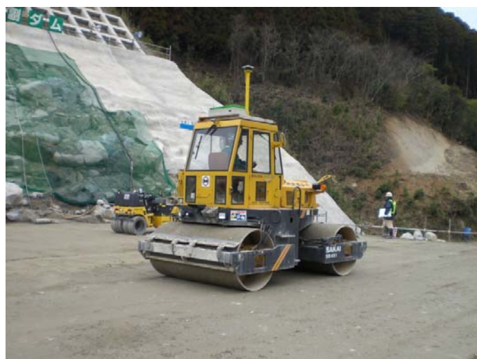
振動ローラ施工状況(近景)
