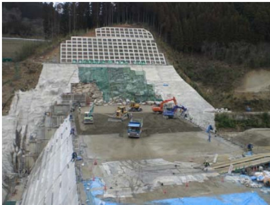
現場遠景(右岸天端より現場を望む)
