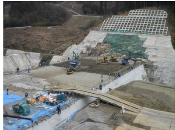
現場遠景(右岸天端より現場を望む)
