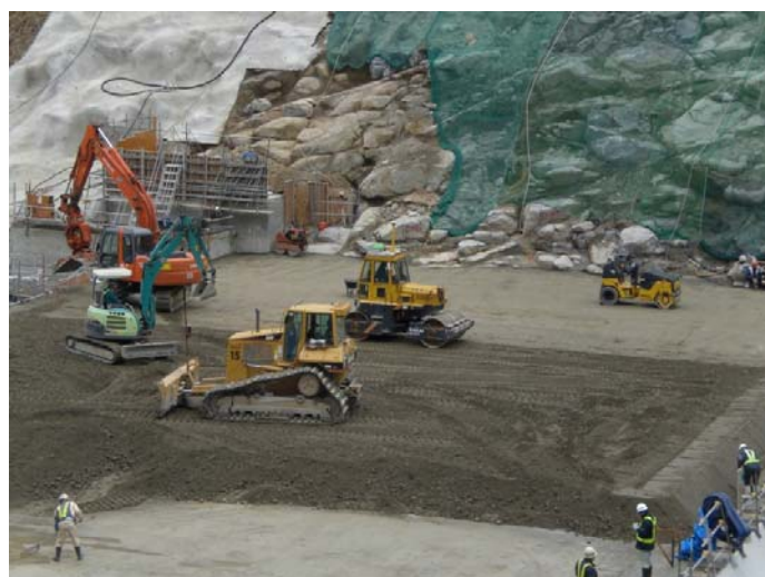
振動ローラ施工状況(遠景)
