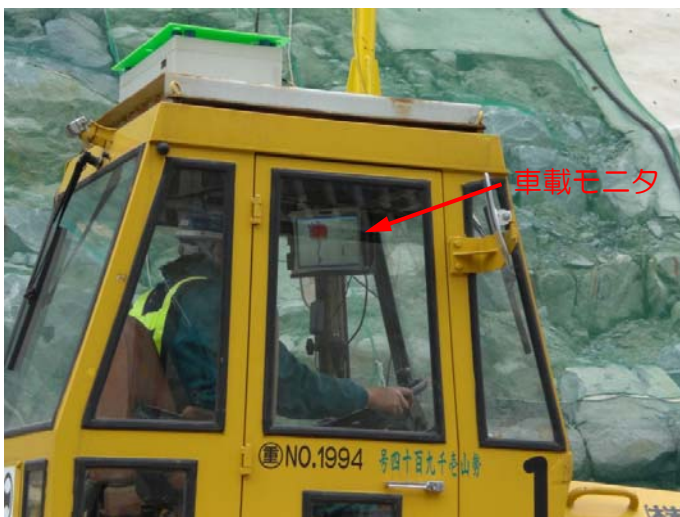
振動ローラ施工状況(コックピット)
