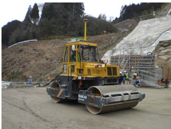
振動ローラ施工状況(近景)
