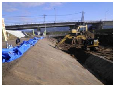
掘削状況 MGBH/GNSS
