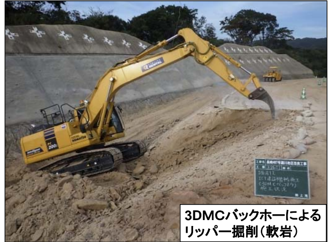
3DMCバックホーによるリッパー掘削(軟岩) モニター確認
