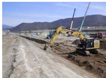
掘削状況 MGBH/TS
