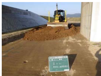
巻き出し状況 MCBD/TS
