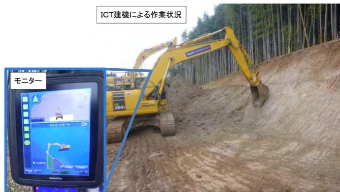
3次元設計データをもとに、MCバックホウを用いて掘削、法面整形を施工。
