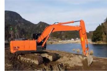
ICT建設機械施工(3次元MG)による掘削
