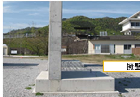
護岸ブロック張・積
