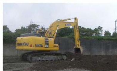
ICT建機(MCバックホウ)による施工
