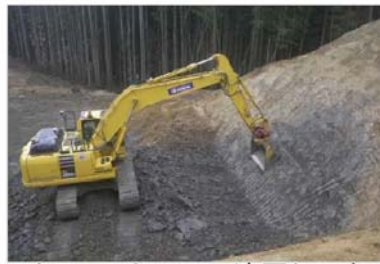
マシンコントロール油圧ショベルによる法面整形
