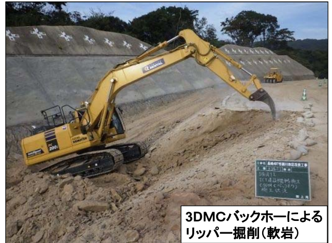
3DMCバックホーによるリッパ掘削(軟岩) モニター確認
