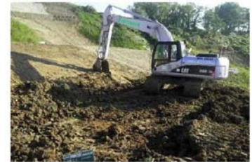
○ ICTバックホウによる法面整形
