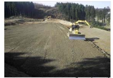
マシンコントロールブルドーザによる盛土敷均し
