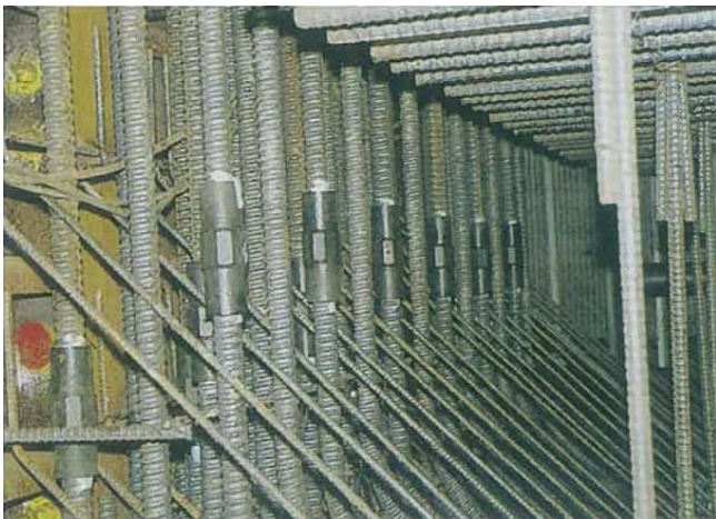
地下構造物施工例
