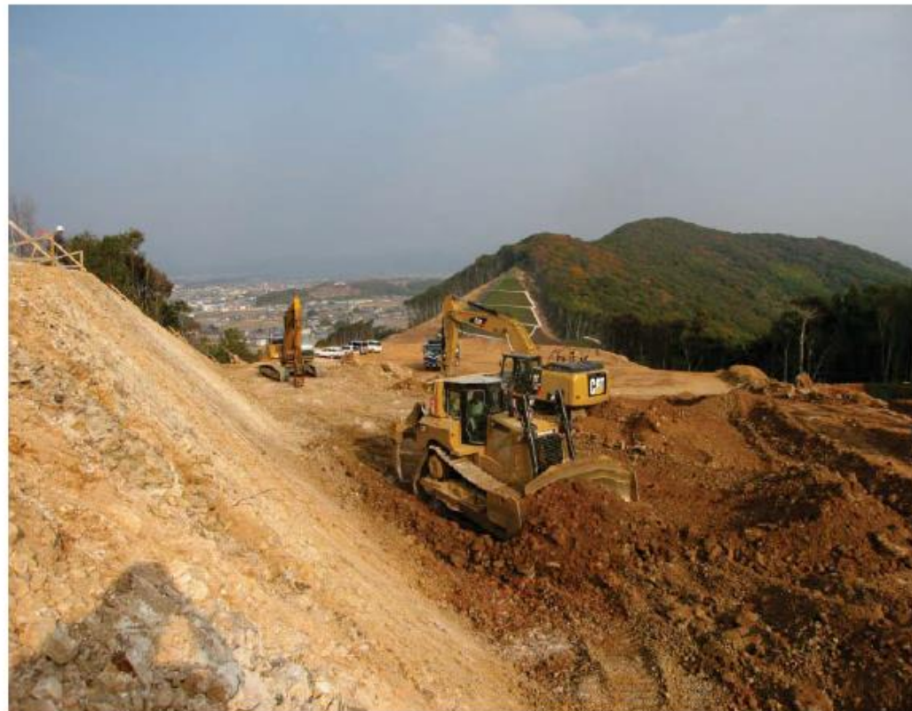
掘削(切土)施工中
