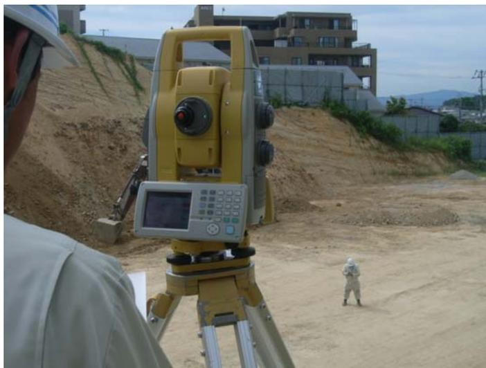
(三次元設計データを用いた計測及び誘導システム)
