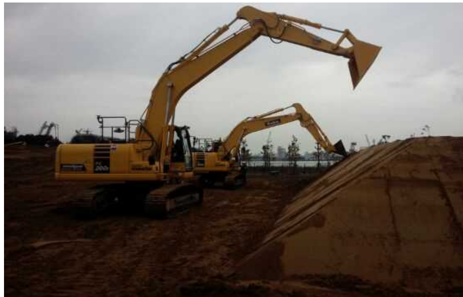
ICT建機による施工
