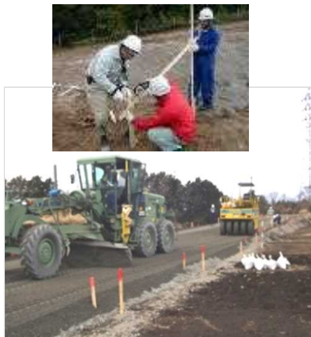
丁張りによる施工
