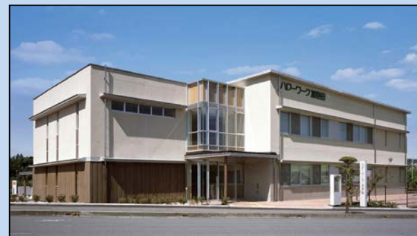
加世田公共職業安定所(平成26(2014)年度完成)
