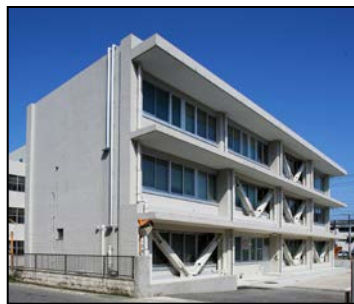
鹿児島地方裁判所名瀬支部 【平成24年度 耐震改修済】
