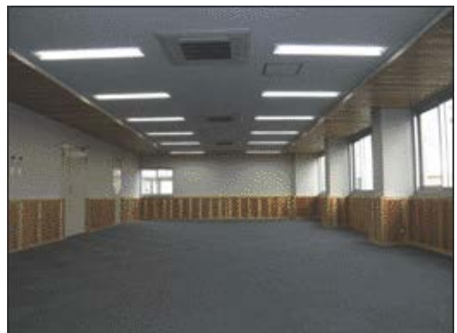
指宿税務署(会議室の腰壁及び天井の一部に木材を利用) 【平成24年度リニューアル】
