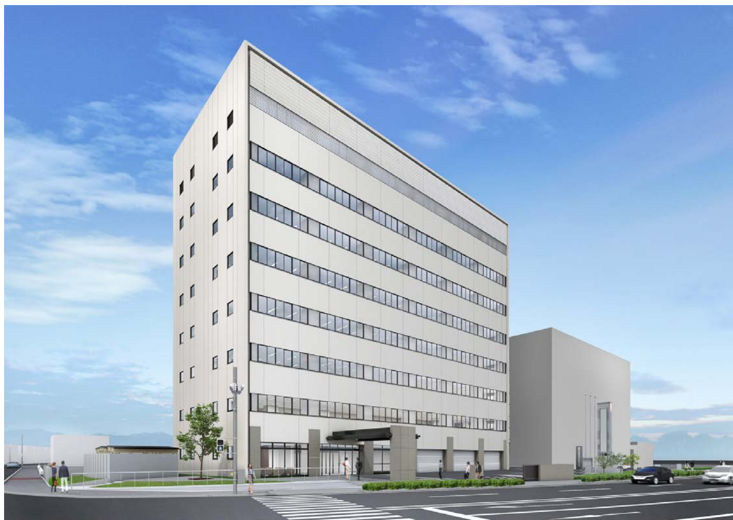
鹿児島港湾合同庁舎【平成30年度完成予定】
