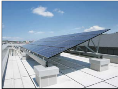
加世田公共職業安定所 (太陽光発電設備) 【平成26年度完成】
