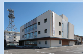
延岡労働総合庁舎 （令和4（2022）年度完成）
