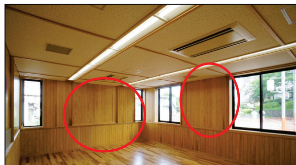
会議室（壁にCLT（直交集成材）を採用）
