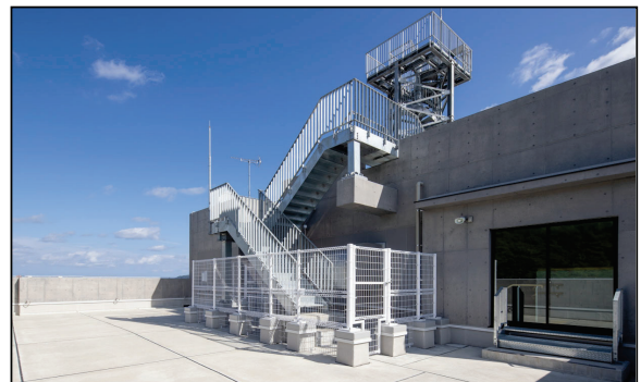
津波避難スペース（屋上）
