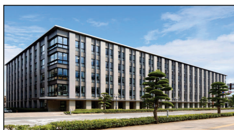
鹿児島第三地方合同庁舎 （縦ルーバーによる西日カット） 【令和5年度完成】
