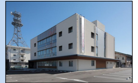
延岡労働総合庁舎 （令和4（2022）年度完成）
