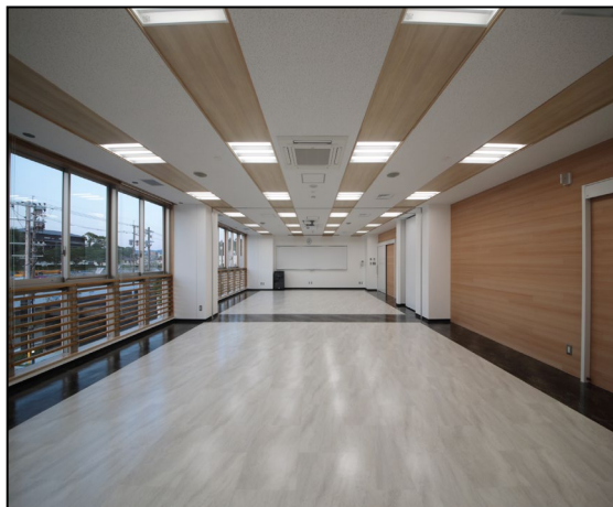
延岡労働総合庁舎（会議室の壁及び天井の一部に木材を利用） 【令和3年度完成】
