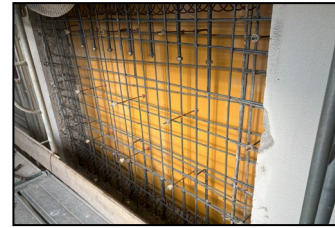
耐震改修 開口閉塞施工写真
