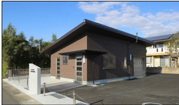
宮之城森林事務所（木造庁舎として整備） 【令和3年度完成】
