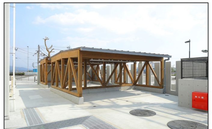
鹿児島港湾合同庁舎（駐輪場に木材を利用） 【平成31年度完成】
