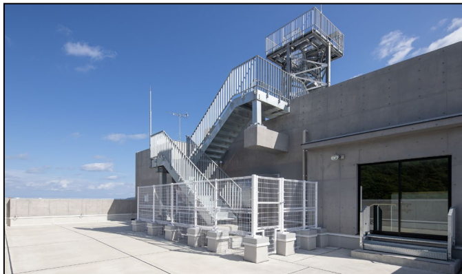
津波避難スペース（屋上）
