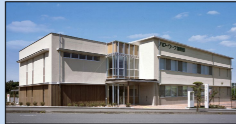
加世田公共職業安定所 （平成26（2014）年度完成）
