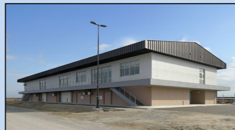
鹿児島海上保安部船艇用品庫 （令和2（2020）年度完成）
