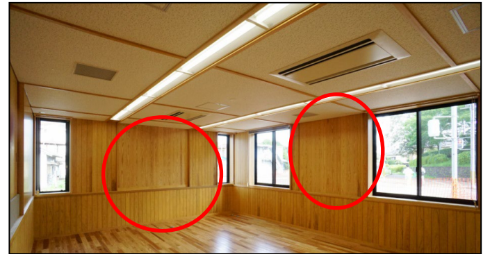
会議室（壁にCLT（直交集成材）を採用）
