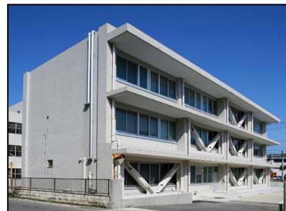
鹿児島地方裁判所名瀬支部 【平成24年度 耐震改修済】
