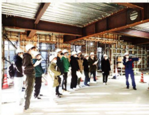
絶賛工事中の2期庁舎の内部
