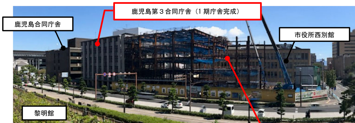
工事進捗状況（令和4年10月時点）
