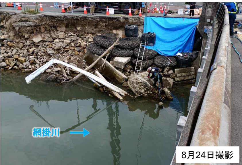
【網掛橋上流側】
