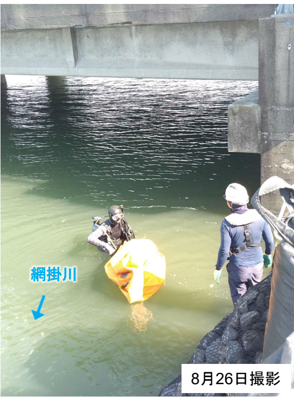
【網掛橋下流側】
