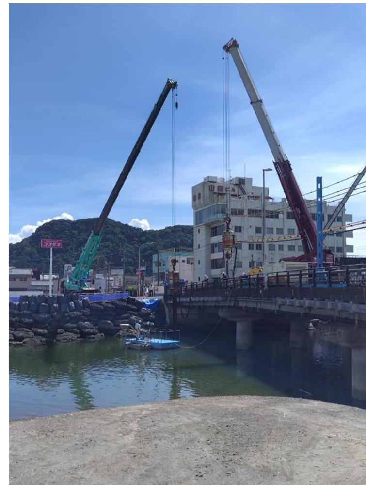
鋼矢板打設状況（9/15 11:00撮影）
