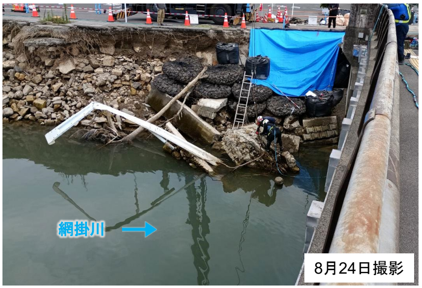
【網掛橋上流側】
