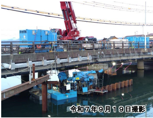
▼鋼矢板設置施工状況
