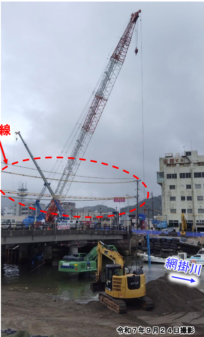
▼200tクレーン (網掛川下流側より撮影)
