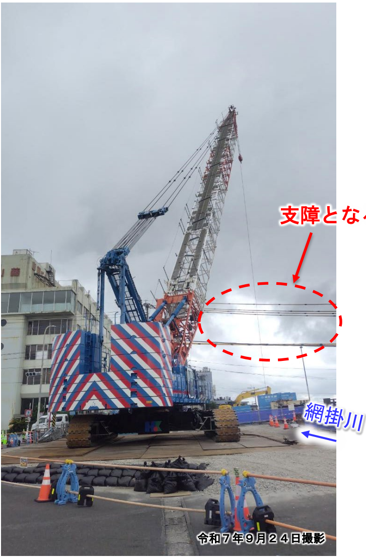
▼200tクレーン (網掛川上流側より撮影)
