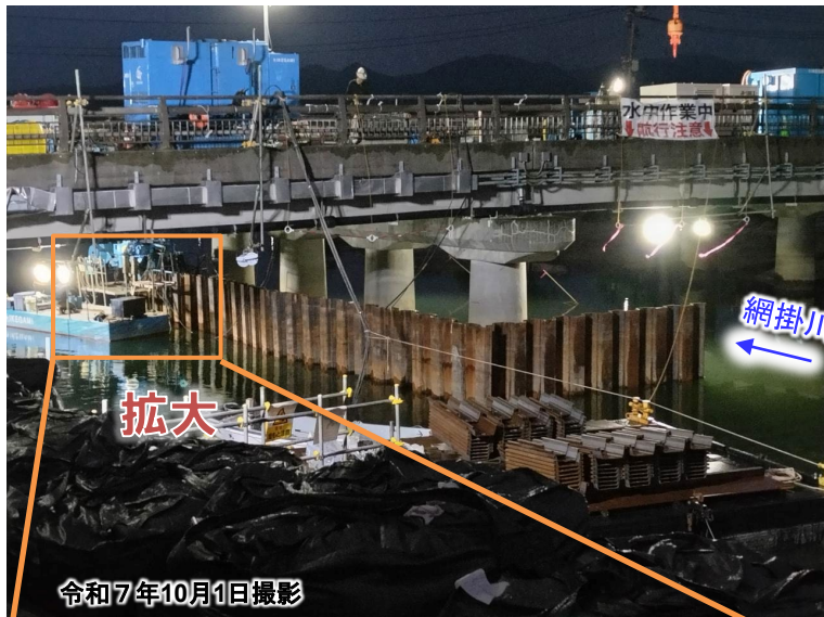
▼桁下に設置している短い鋼矢板
