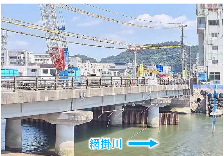
鋼矢板打設状況【下流側より】 （10/7 13:00撮影）
