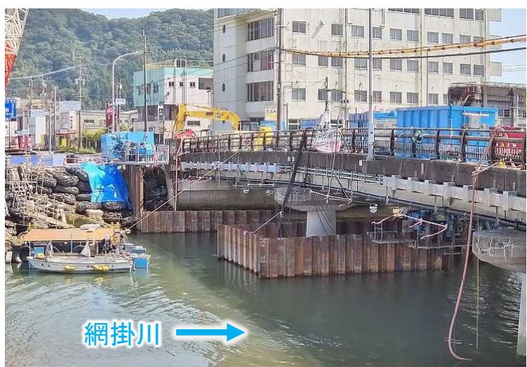
鋼矢板打設状況【上流側より】 （10/7 13:00撮影）
