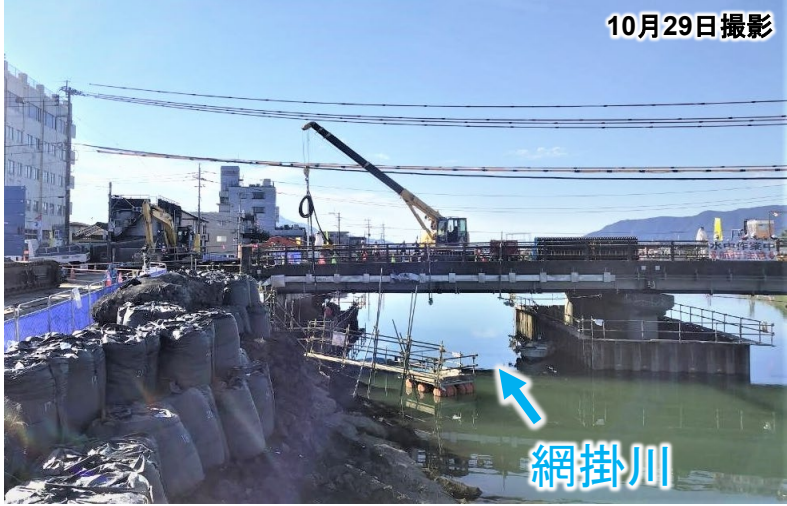
応急復旧（施工中）
