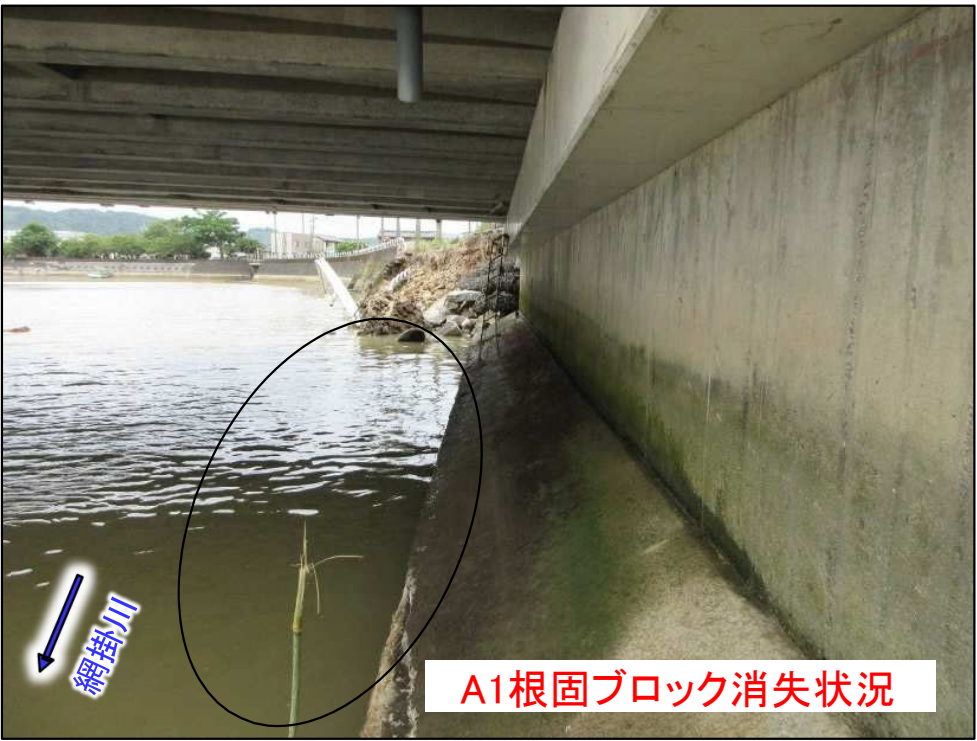
A1根固部(下流側⇒上流側)
