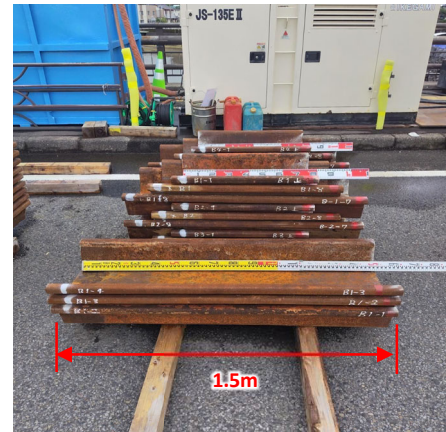
▼桁下に設置する短い鋼矢板
