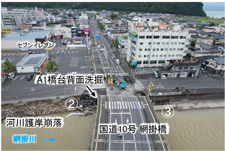
写真② 【上流側護岸の被災状況】
