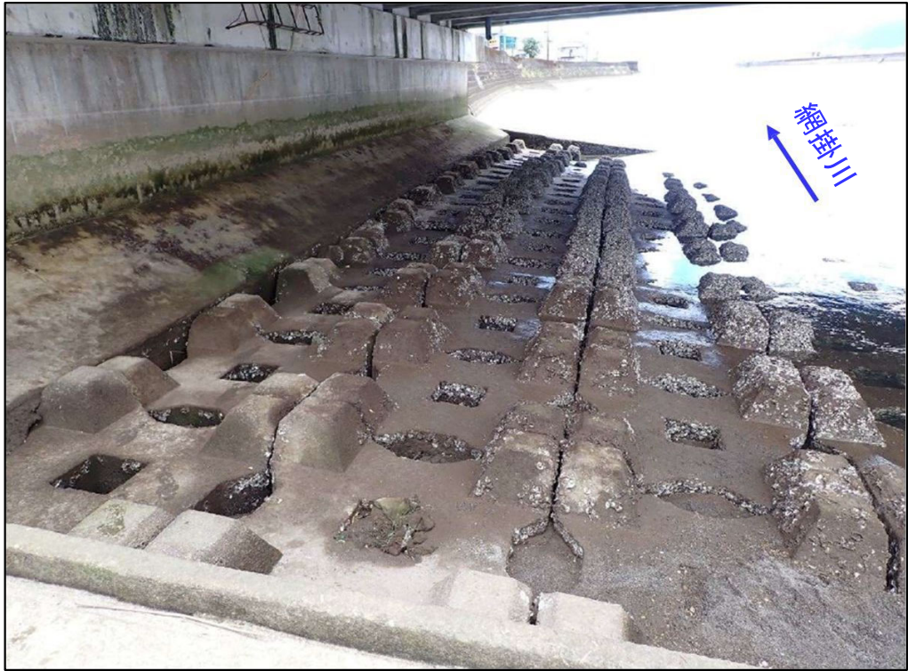
A1根固部(上流側⇒下流側)
