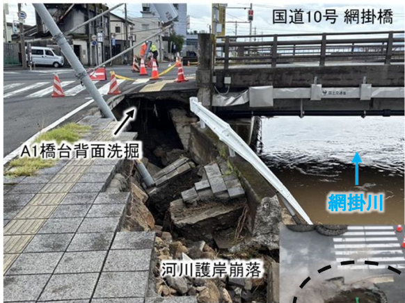
写真② 【上流側護岸の被災状況】
