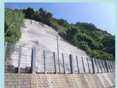
モルタル吹付
