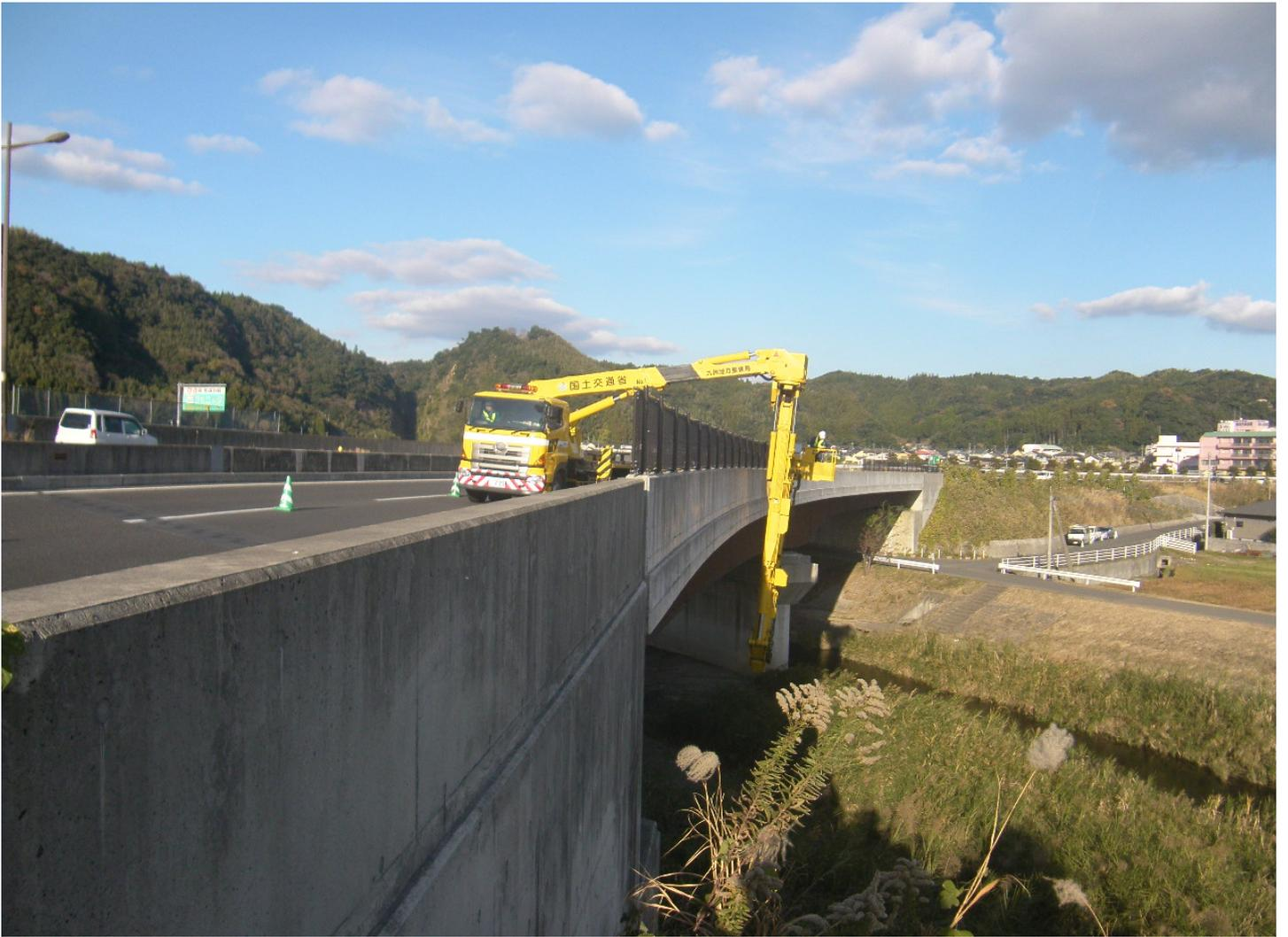
写真 橋梁点検車による近接状況調査作業状況(イメージ)
