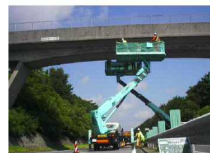
点検実施状況
