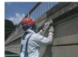
補修実施状況
