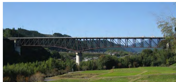
<乙姫大橋の状況>
