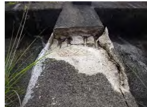
法砕工の老朽化損傷
