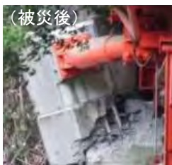
制震ダンパー取付部の損傷
