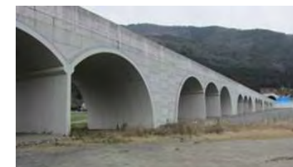
アーチカルバート
