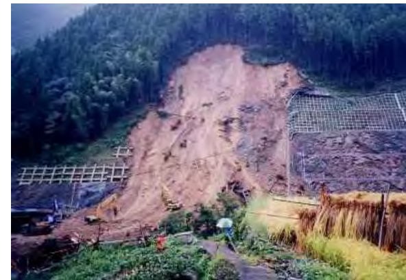
強風化・土砂化斜面での崩壊例
