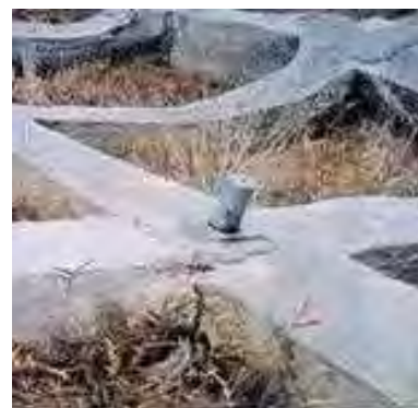
写真 受圧構造物の破損の例
