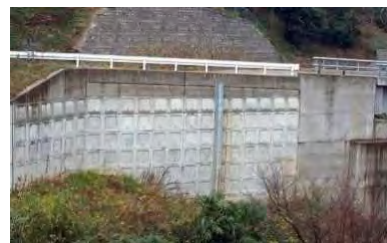
盛土（補強土壁）
