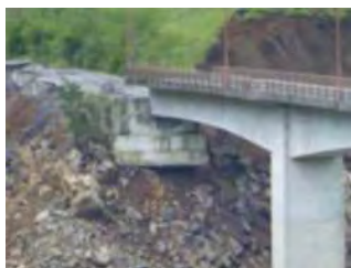
斜面変状による橋台の沈下
