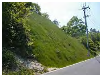
切土(法面保護)
