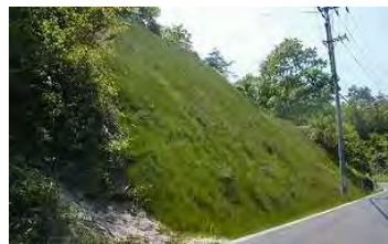
切土（のり面保護）
