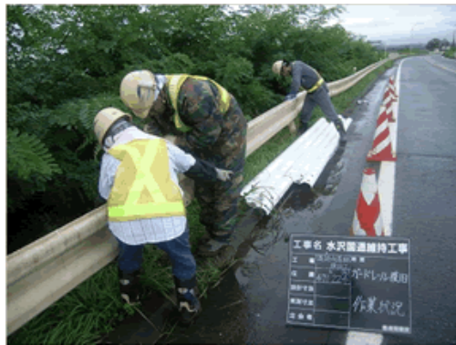
<防護柵の取替>
