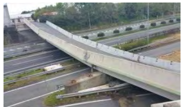
ロッキング橋脚を有する橋の落橋
