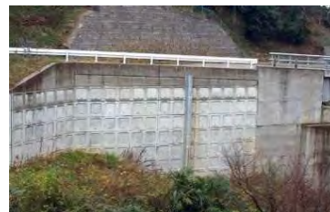
盛土(補強土壁)
