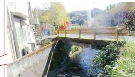
老朽橋の撤去
