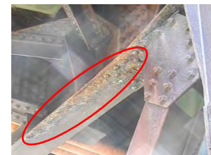
耐候性鋼材に層状の剥離
