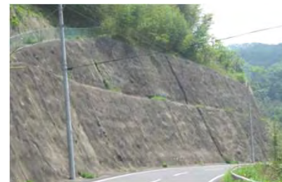
モルタル吹付
