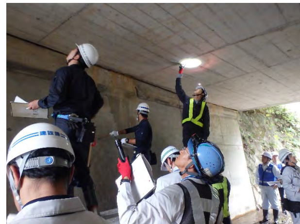
点検実施状況
