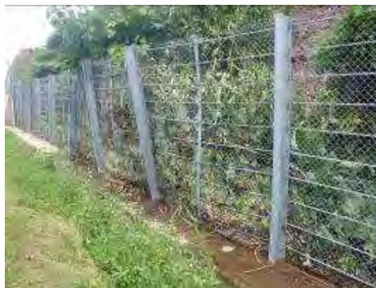
写真 落石防護柵の傾動の例
