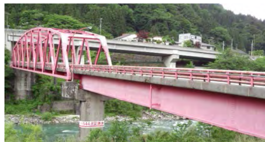
<音沢橋の状況>
