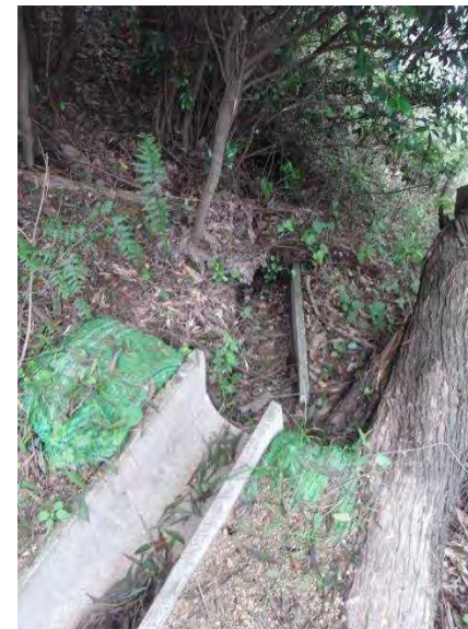
写真 排水溝の破損の例
