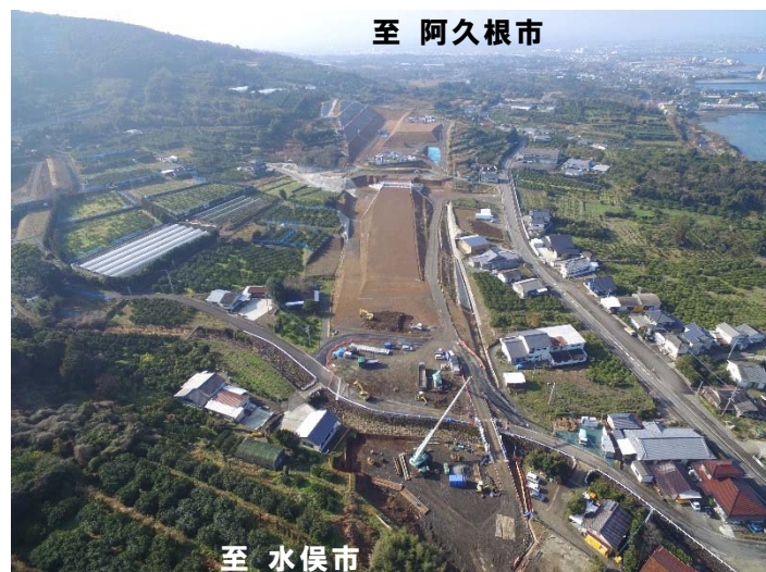
出水北 IC（仮称）付近 施工状況
