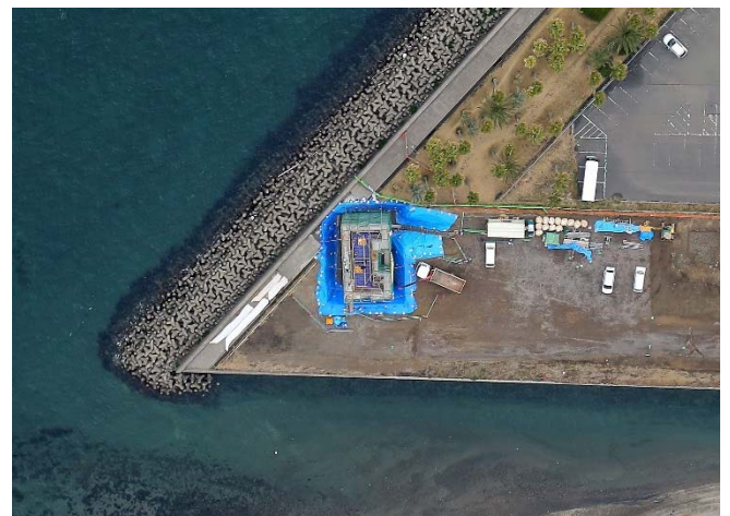
祇園之洲橋(仮称)A2橋台
