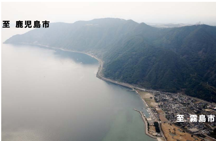
4車化整備区間全景
