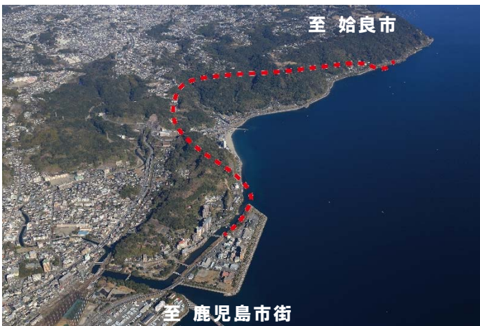
鹿児島北バイパス全景
