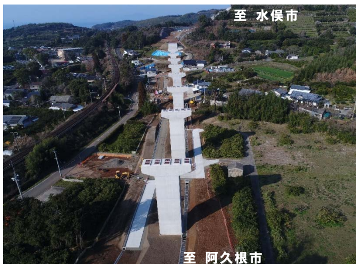
前田川橋（仮称） 施工状況
