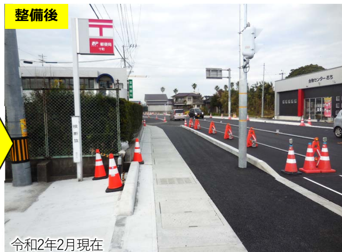
枕崎市側から鹿児島市方面を望む
