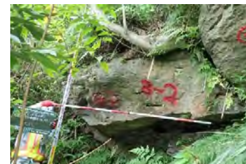
写真② 斜面の不安定な岩盤
