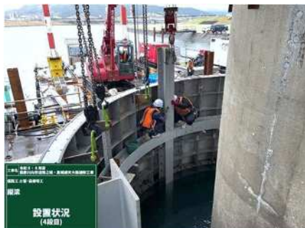
コンクリート巻立工
