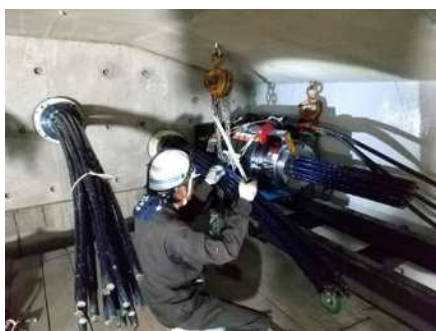
外ケーブル補強工
