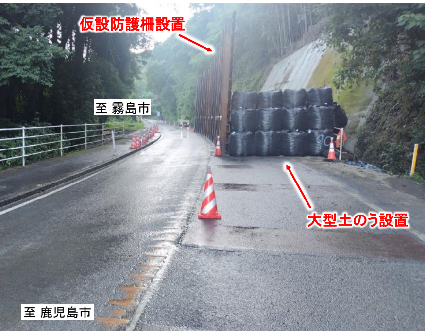
【応急復旧完了後の状況】
