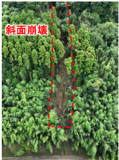
【国道上部斜面の崩壊状況】
