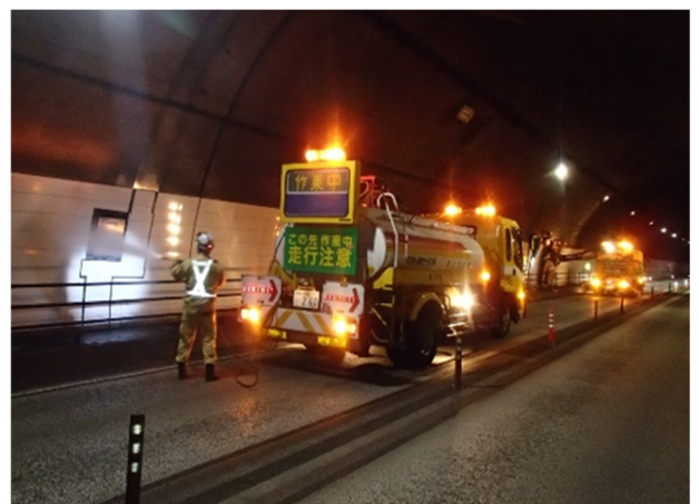
トンネル清掃
