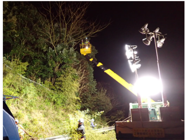
のり面伐採工事
