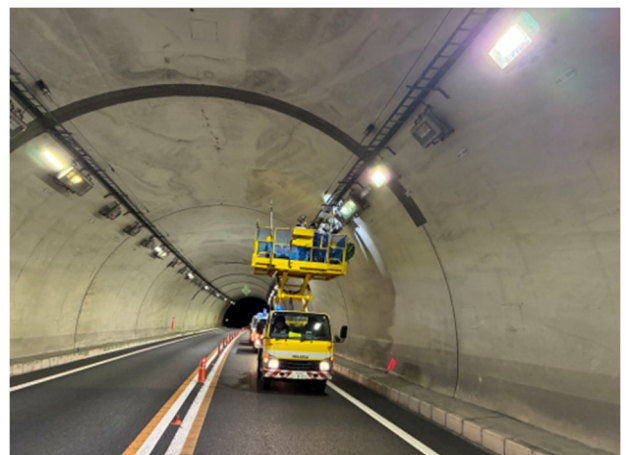
照明取替工事
