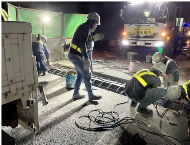
伸縮装置取替工事
