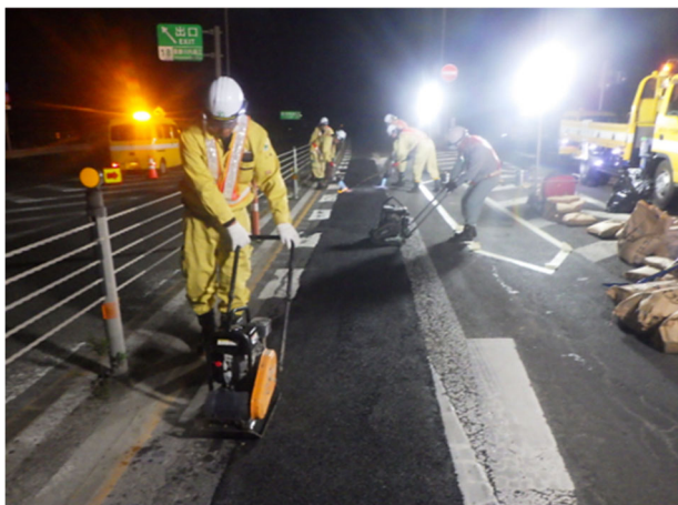
舗装修繕工事
