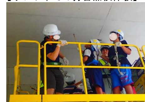
【リフト車での打音点検体験】
