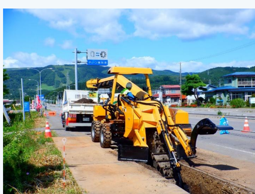
【トレンチャー掘削】
