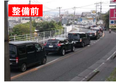
▲右折車線滞留超過状況
