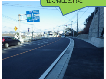
歩道の幅が広くなり歩行者の安全性・快適性が向上された
